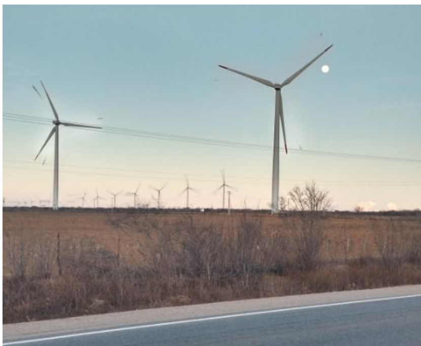
Figura 18 – Parque Eólico no Rio Grande do Norte
